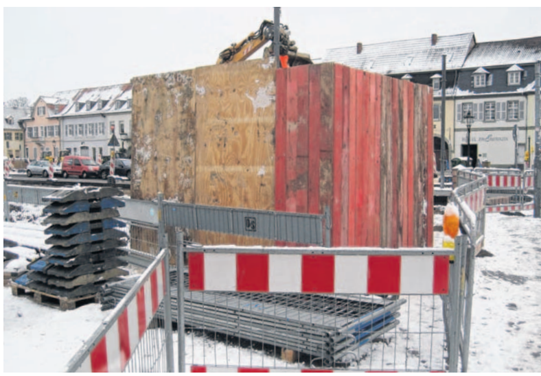
Bei den derzeitigen Temperaturen hat das Spargelfrau-Ensemble einen „Unterschluß“ gefunden: Der Brettverschlag soll das Kunstwerk aber weniger vor der Kälte als vielmehr vor Beschädigungen während der Bauphase schützen.
